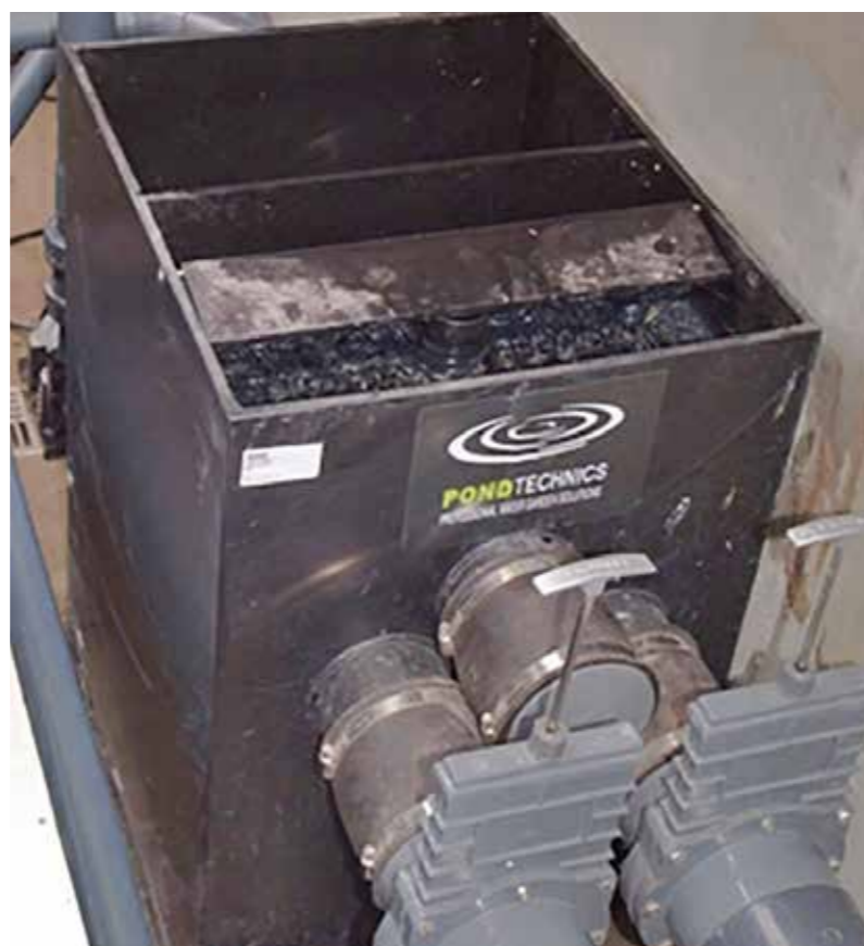
Pond Sieve en combinaison avec Skimmer satellite de Pond Technics, unité UV-c Pond Clean et pompes Eco-Tec 2 de Messner.
